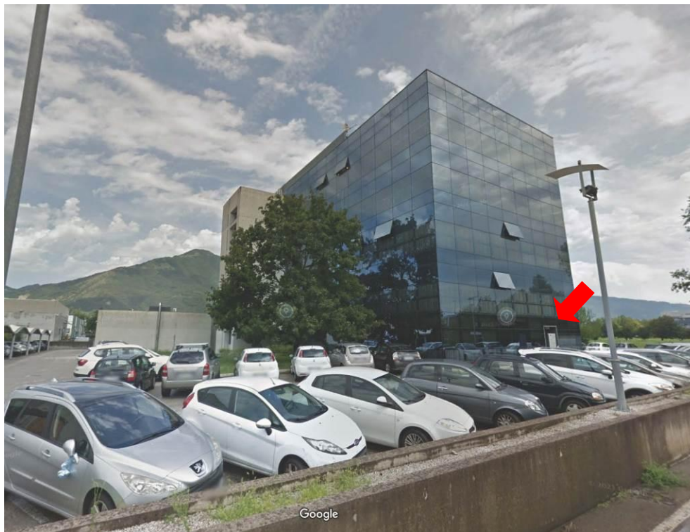
Figura 2 - Palazzina con individuazione ingresso uffici CCIAA
