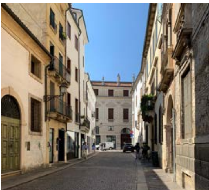
Palazzo Caldogno visto da contrà Riale
