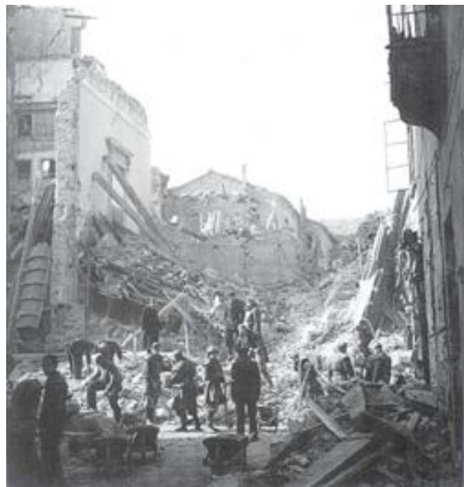
Palazzo Caldogno visto da contrà Riale.
